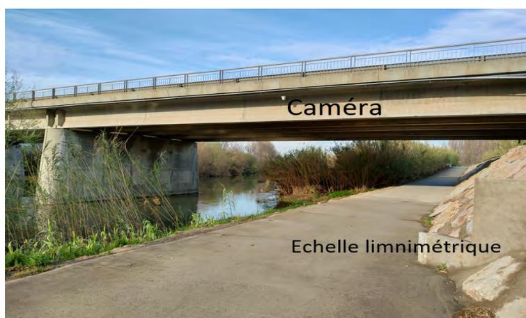
FIGURE 14 – Caméra et échelle de crue sur la rive gauche de a digue de l’Agly (© Julie.D)
